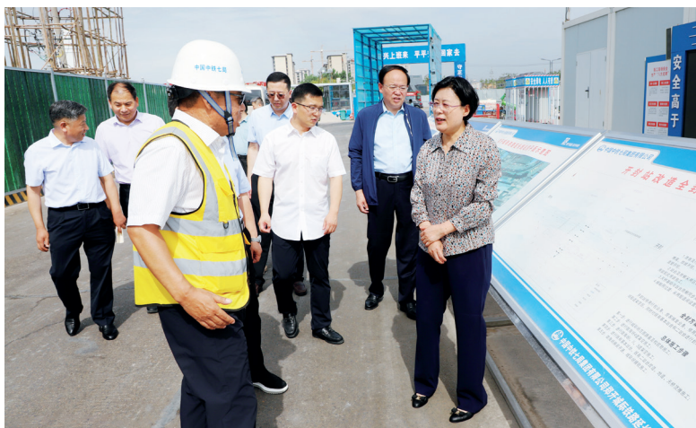
开封市人大常委会主任方婷带队视察火车站站前综合交通枢纽项目建设情况
