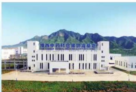
民生药业集团豫西中药材仓储物流基地
